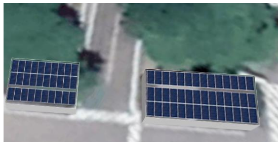
Painéis fotovoltaicos - área do estacionamento da sede
