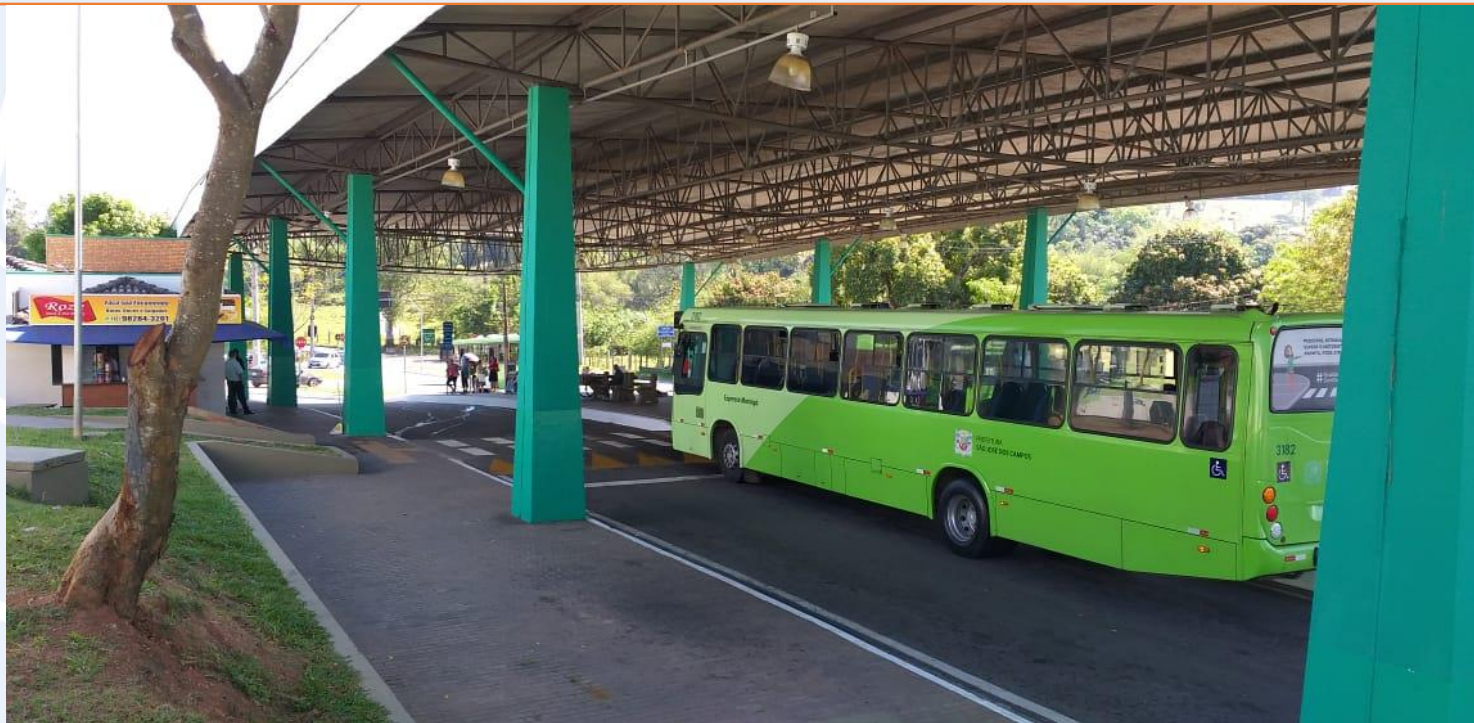
Pintura, manutenção, sinalização e LEDs - ECO (Estação de Conexão) Campos de São José.
